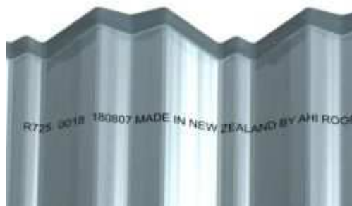
Označení výrobní šarže na spodní straně šablony
